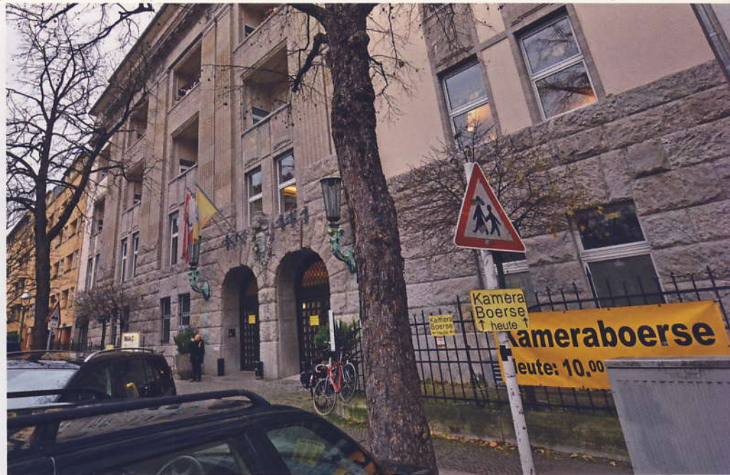
Das Logenhaus in der Emser Straße von Berlin-Wilmersdorf, unweit vom Kurfürstendamm, ist schon von seiner Lage her ein sehr guter Veranstaltungsort für die Europäische Kamerabörse
